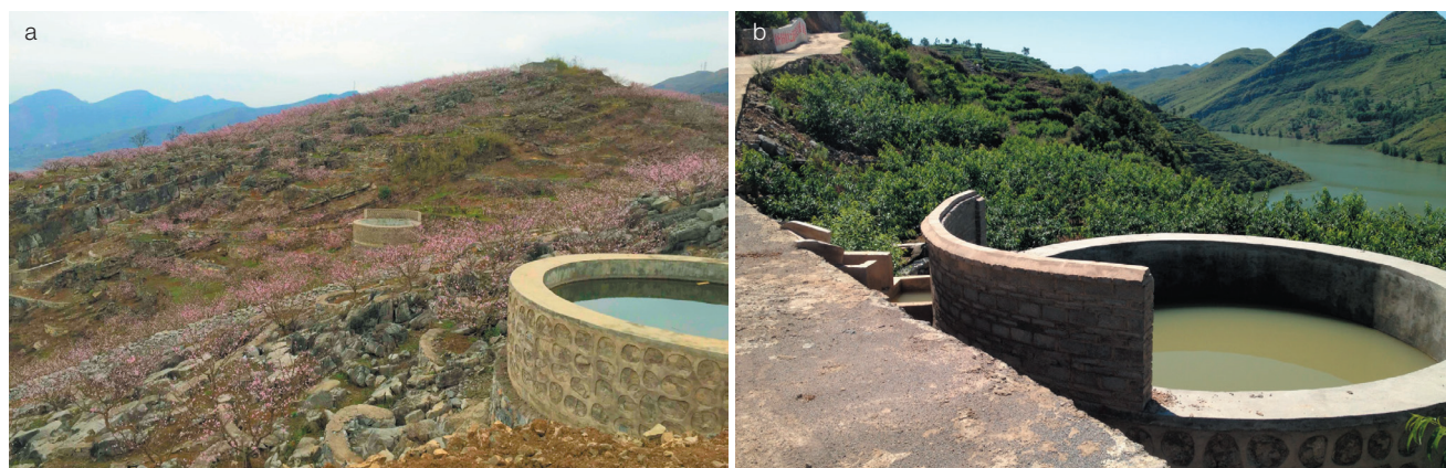
图4 路-池集雨蓄水表层水资源高效综合利用技术
