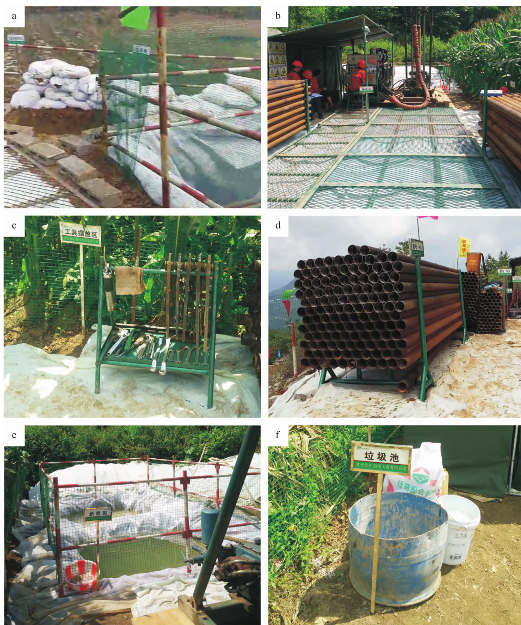
a. 机台开挖覆土装袋存放管理;b. 施工区铺设防滑钢网和铺垫土工布;c. 工具架空摆放和铺垫土工布;d. 钻具架空堆放和铺垫土工布;e. 防渗漏处理的泥浆池;f. 机台设置垃圾池
